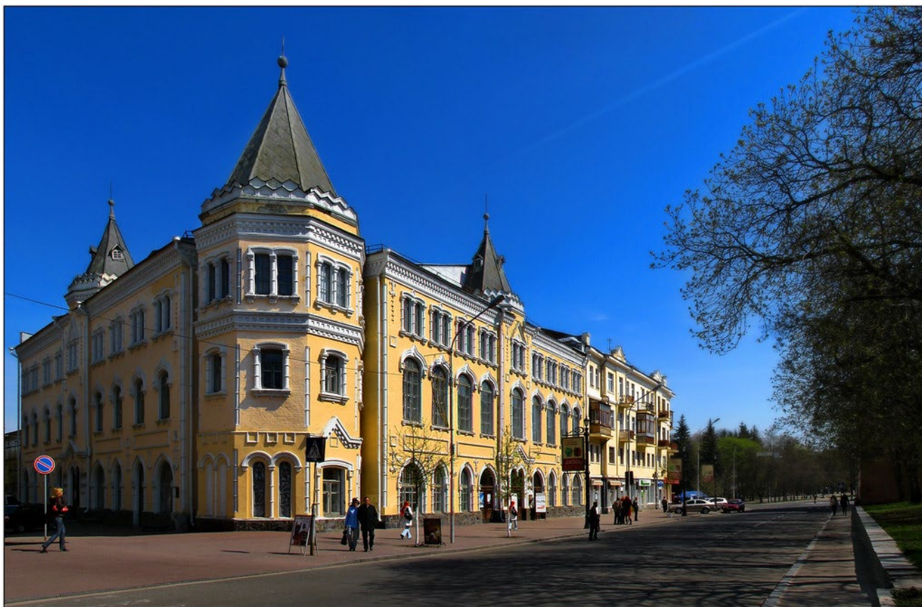
Рисунок А.1 – Зовнішній вигляд будівлі Чернігівського обласного філармонійного центру фестивалів та концертних програм
