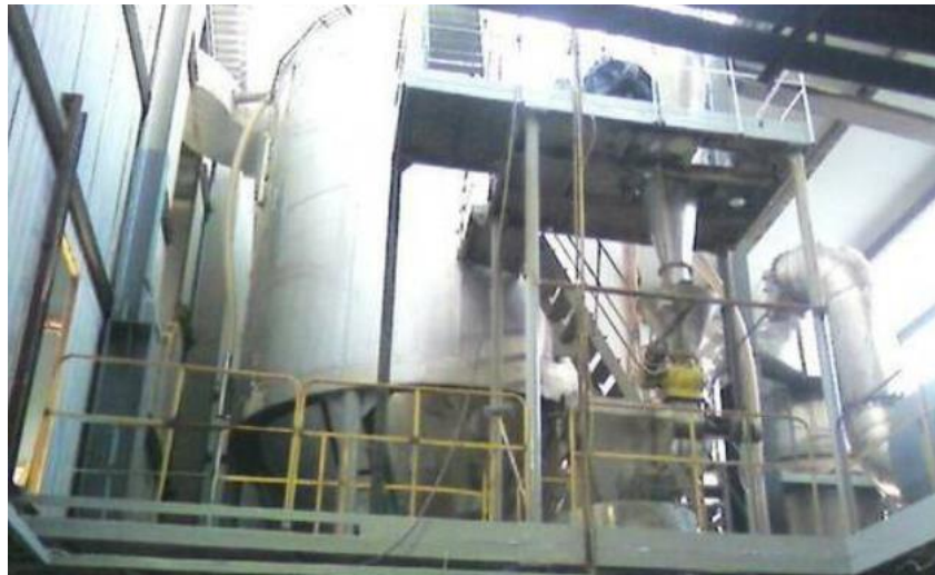
Рис. 2.6. Установка сушильна розпилювальна VRS-3
