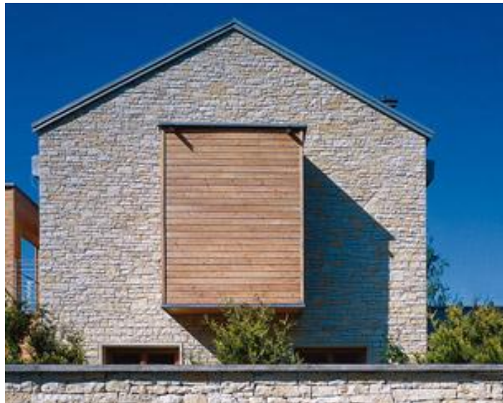
Рис. 15.17 Деталі з деревини прекрасно доповнюють кам'яний фасад. Вони надають йому легкість і поживляють монотонність важкої стіни, виконаної з вапняку
