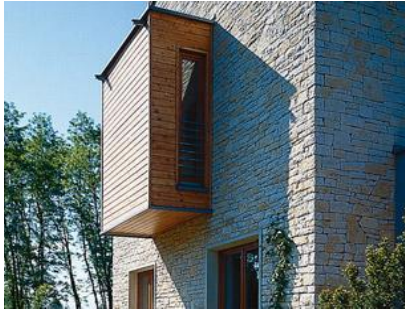
Рис.15.18. Облицювання надбудови, що виступає, виконане з деревини. Вона легка, до того ж добре поєднується з вапняком. Щоб облицьовувати її важкими каменями, довелося б кріпити їх дорогими анкерами.
