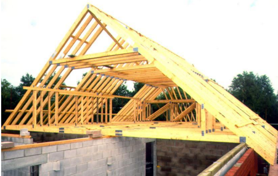
Рис. 12.5. Несиметрична ферма
