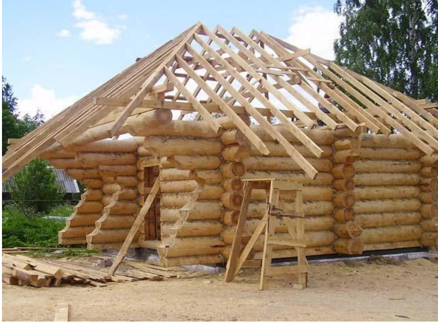
Рис.14.8. Монтаж даху будинку
