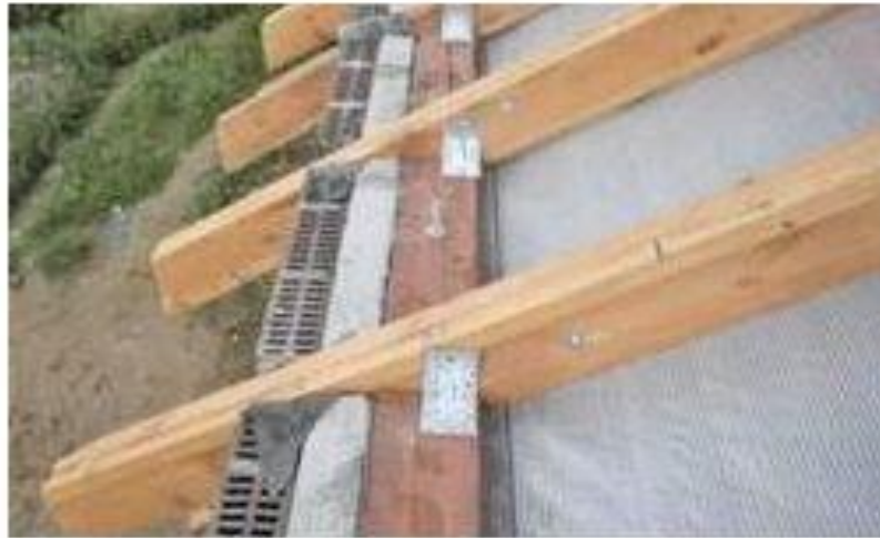
Рис. 14.12. З'єднань крокв з стіною будівлі
