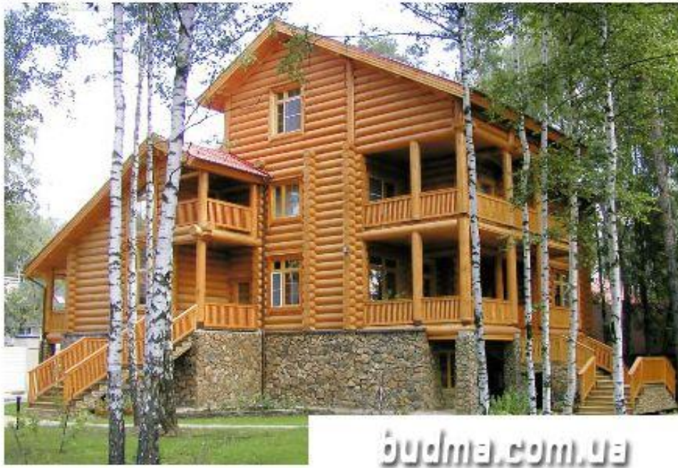
Рис. 15.10. Загальний вигляд будинку з кругляка (варіант III)
