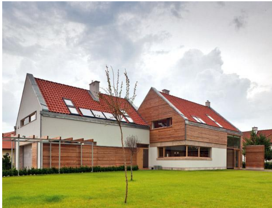
Рис. 15.15. Оздоблення стін одноповерхового будинку з мансардою у поєднанні сибірської модрини і штукатурки.
