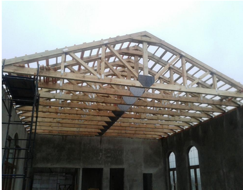
Рис. 12.1. Загальний вигляд ферми перекриття
