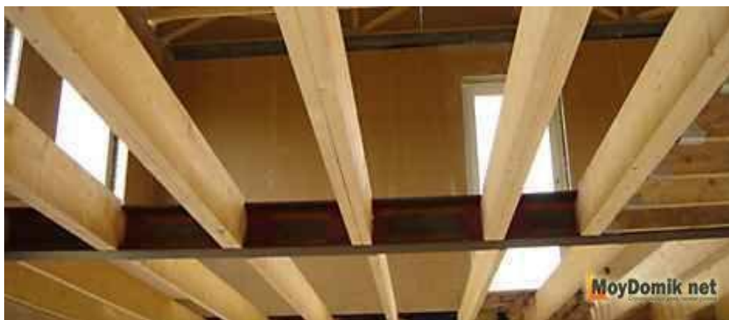
Рис.10.1. Дерев'яне балочне перекриття
