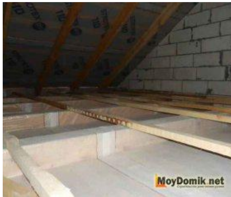
Рис.10.4. Перекриття на дерев'яних балках
