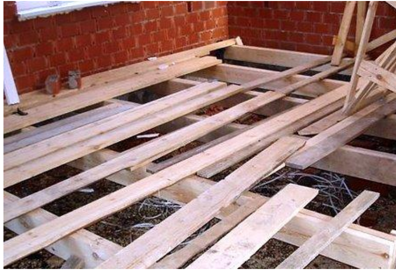
Рис. 9.4. Установка лаг на грунті
