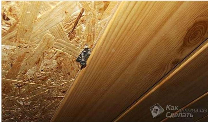
Рис.8.3. Монтаж панелі з деревини
