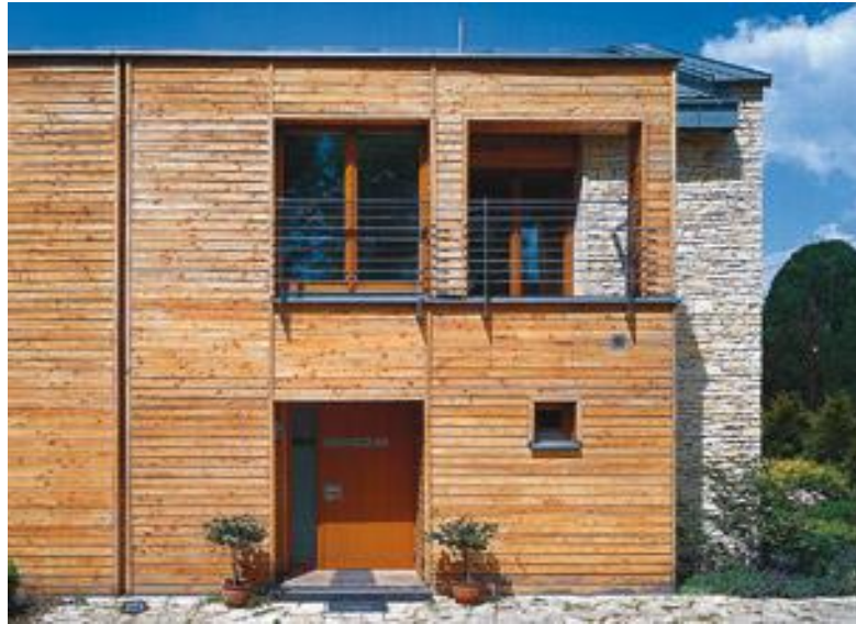
Рис.15.16. На стінах з бетону і газобетону укладені дошки різної довжини. Вони кріпляться до дерев'яного каркаса, а місця з'єднання приховані вертикальними планками.
