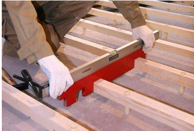
Рис.9.2. Установка лаг для підлоги
