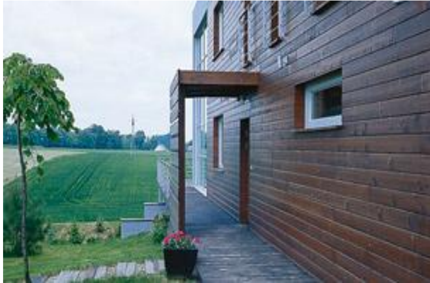
Рис.15.23. Головний вхід виділяють дошки шириною 22см, укладені упереміш із смугами з прозорого оргскла. Це надає входу легкість.
