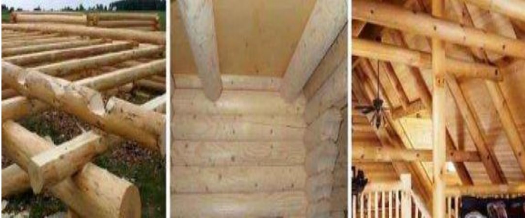
Рис. 10.8. Дерев'яні балки круглого перетину
