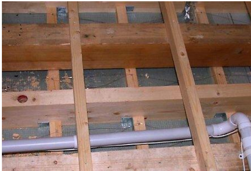
Рис. 9.3. Установка лаг на перекриття
