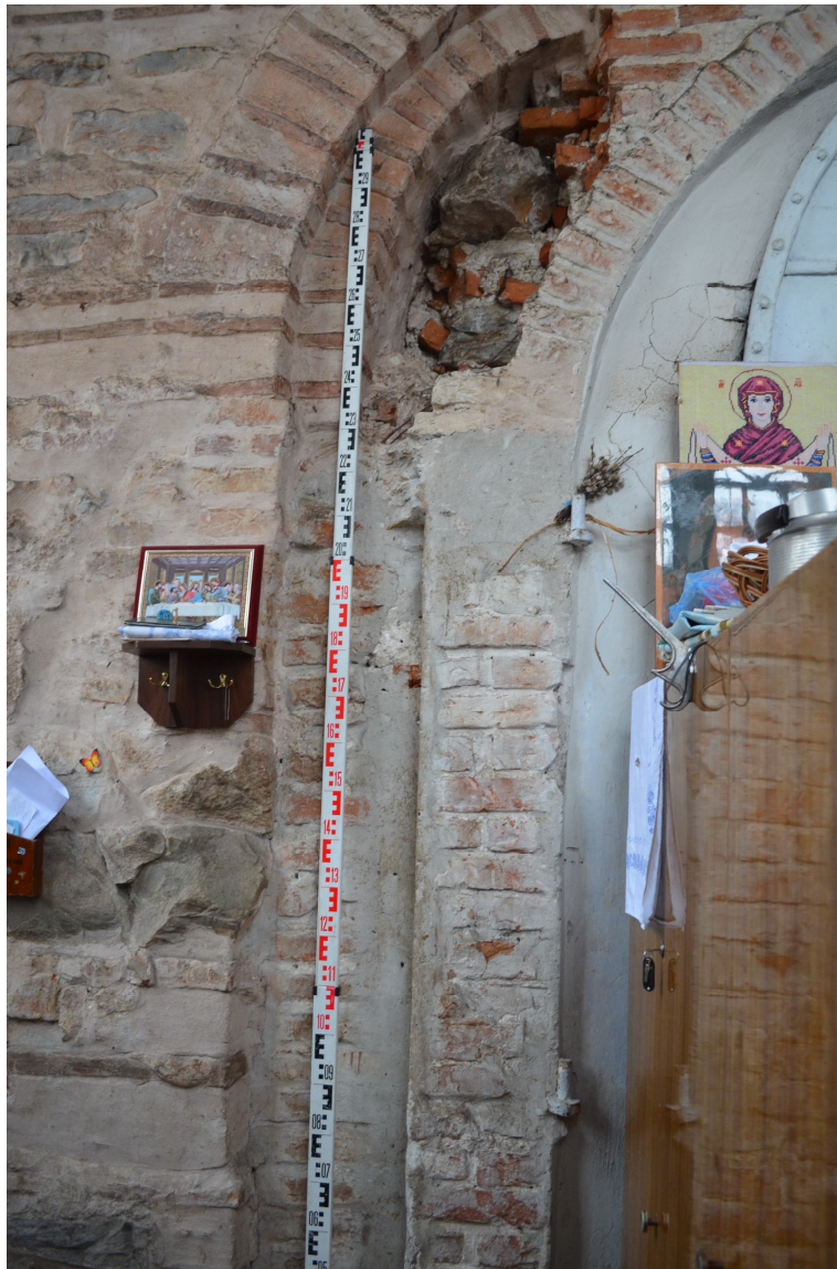
Рис. 18. Мурування XVII–XIX ст. в обрамленні північного порталу Спасо-Преображенського собору (початок XI ст.) в Чернівці. Фото 2014 р.
