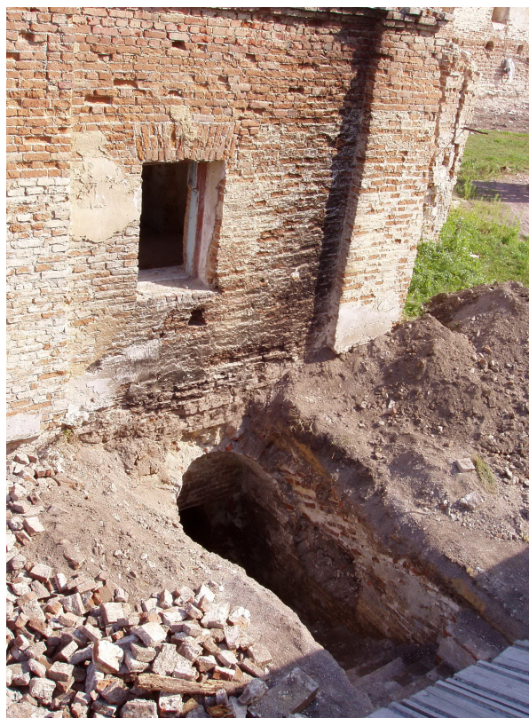
Рис. 8. Вхід до підземного комплексу XVIII ст. під «корпусом на льохах» у Спасо-Преображенському монастирі в Новгороді-Сіверському. Фото під час реставрації 2003 р.
