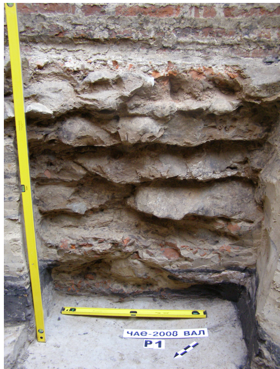
Рис. 26. Плитняк в основі фундаментів Чернігівського Коллегіуму. Фото 2008 р.
