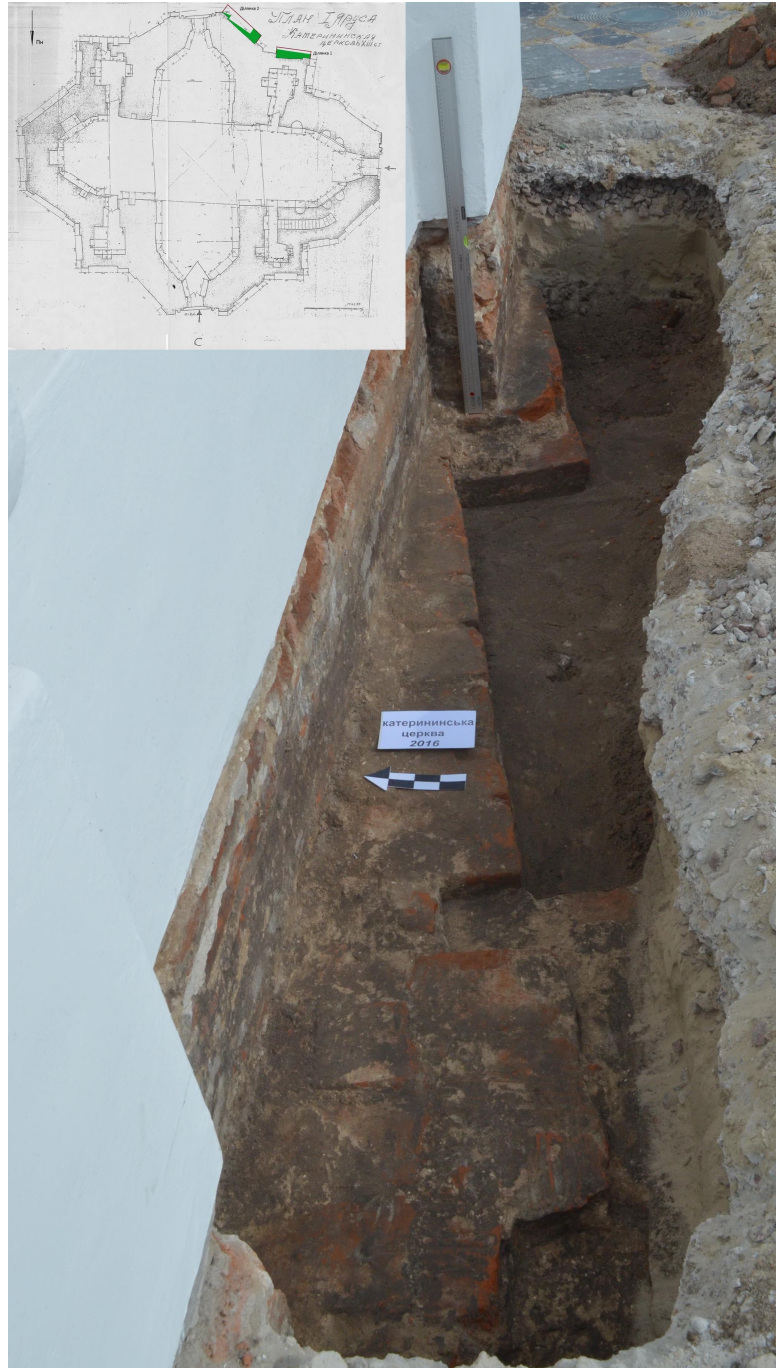
Рис. 24. Виступ фундаменту Катерининської церкви 1715 р. із позначенням розкритих ділянок на загальному плані споруди (за матеріалами досліджень 2016 р.)
