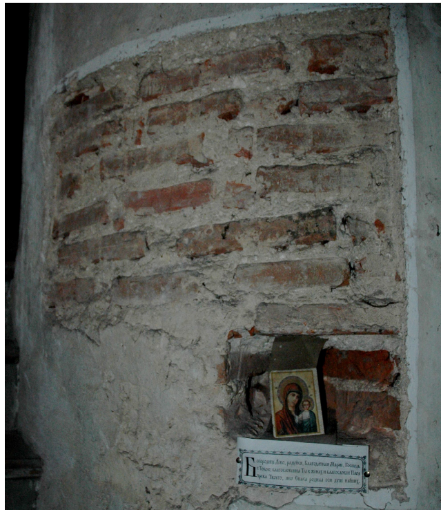
Рис. 39. Ремонтне мурування (XVII ст.) закругленої поверхні опорного стовпа сходової вежі Спасо-Преображенського собору в Чернігові. Фото 2012 р.
