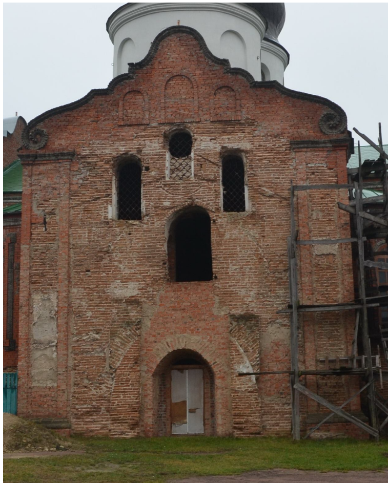
Рис. 19. Різночасові мурування та сліди примикання прибудов на фасаді Спасо-Преображенської церкви (1757 р.) у Ніжині. Фото 2017 р.
