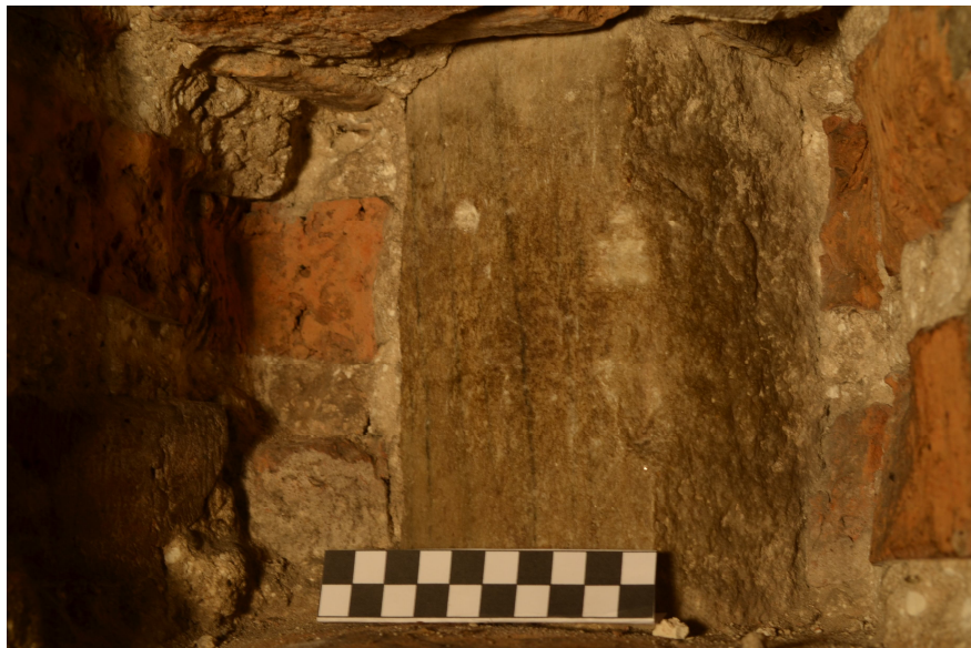
Рис. 23. Мармуровий бордюр з давньоруським графіті у ремонтному муруванні з цегли пальчатки (XVII ст.). Зондаж у південно-західній колоні Спасо-Преображенського собору в Чернігові. Фото 2014 р.
