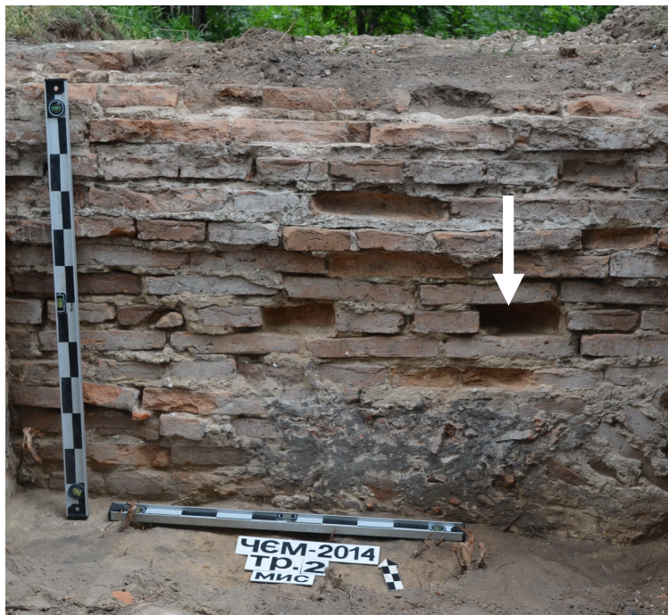
Рис. 29. Залишки стіни Єлецького Свято-Успенського монастиря (XVIII ст.). Стрілкою позначено гніздо від кріплення риштування. Фото 2014 р.
