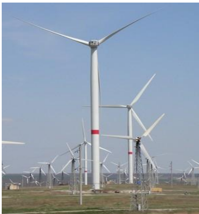
Рис. 3.52 Новоазовська вітрова електростанція
