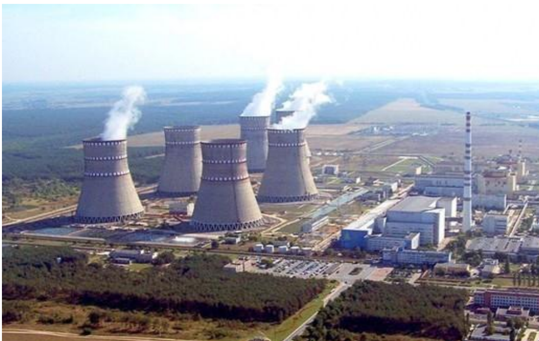
Рис. 4.31 Рівненська атомна електростанція, Кузнецовськ.
