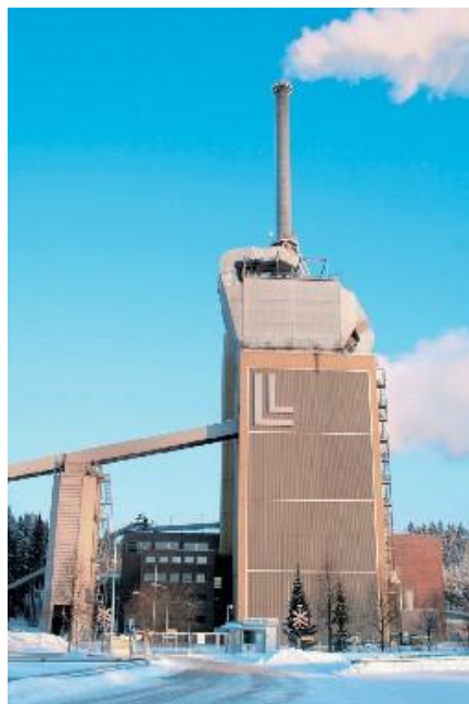
Рис. 3.54 Пилевугільна станція «Куміярві» (Фінляндія), де одночасно спалюється сміття з вугіллям при роздільній їх подачі.
