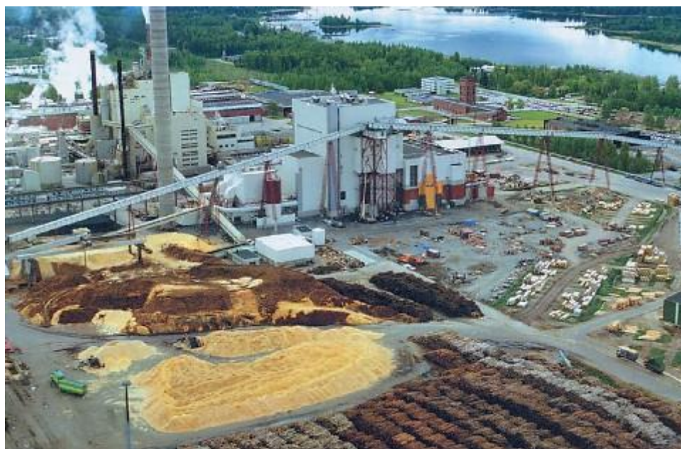
Рис. 3.62 Паливний склад ТЕЦ «Albolmens Kraft-2» (Фінляндія), яка спалює відходи деревообробних підприємств
